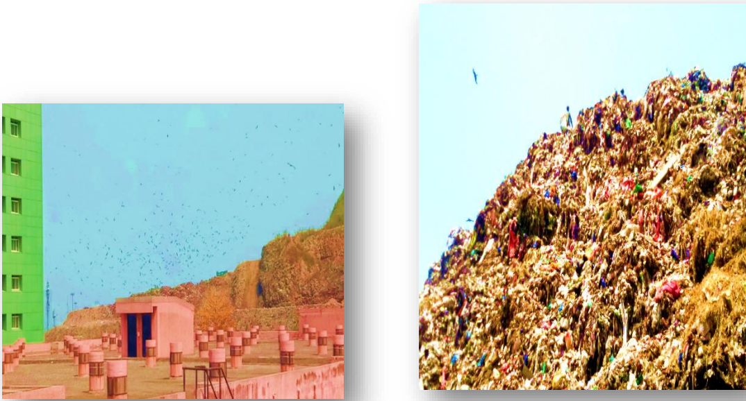
Fig: 2 OkhlaLandfill( a and b)
